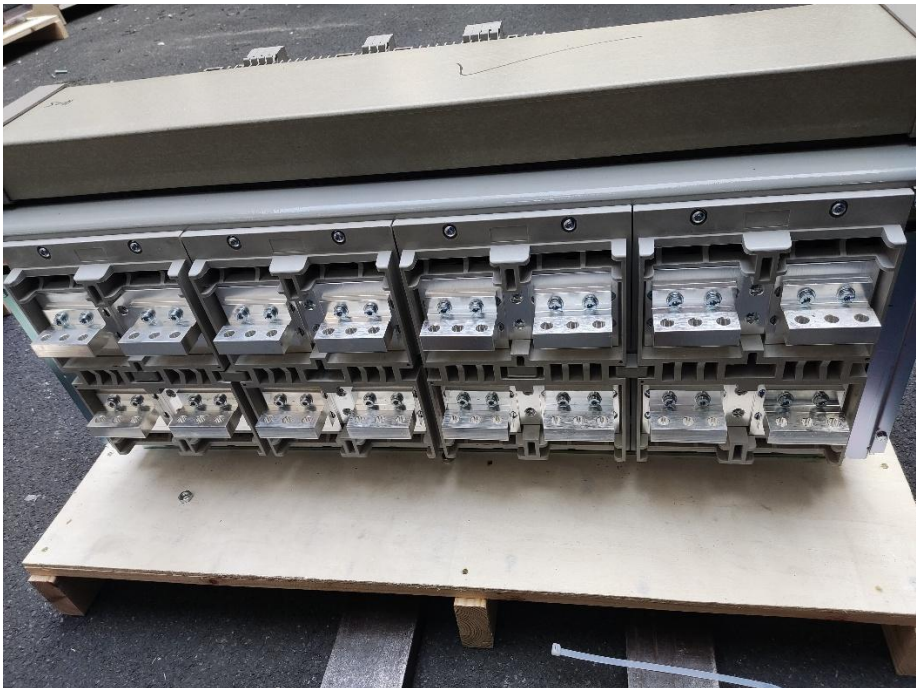
CDW6i-6300R 4000A/4P 接线端子照片
