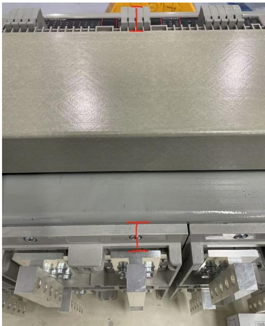
不同电压的电路导体之间电气间隙
